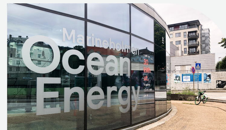
Marineholmen Ocean Energy Byggeår 2011
