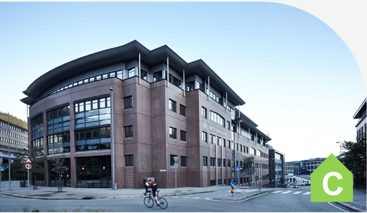
Motorhallen – Kontorbygg | 18.500 m²
