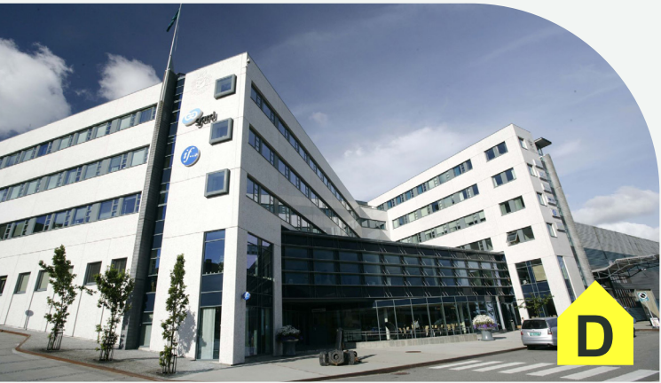
Skipsbyggerhallen – Kontorbygg | 12.200 m²
