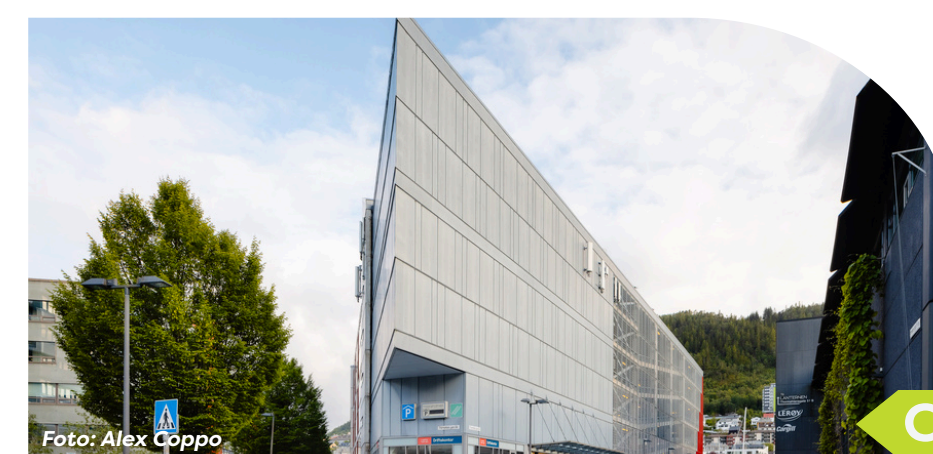
Magasinet – P.hus og kontor | 14 000 kvm Thormøhlens gate 53 E, 5006 Bergen
