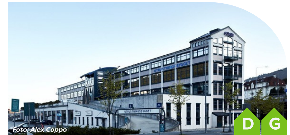
Helsehuset – Sykehus og kontorbygg | 10 800 kvm Solheimsgaten 9, 5058 Bergen
